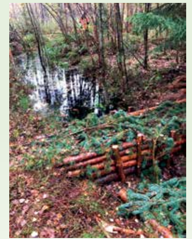
Syyskuussa kaksi viikkoa Terrisuon padon rakentamisen jälkeen vesi on noussut lupaavasti.
