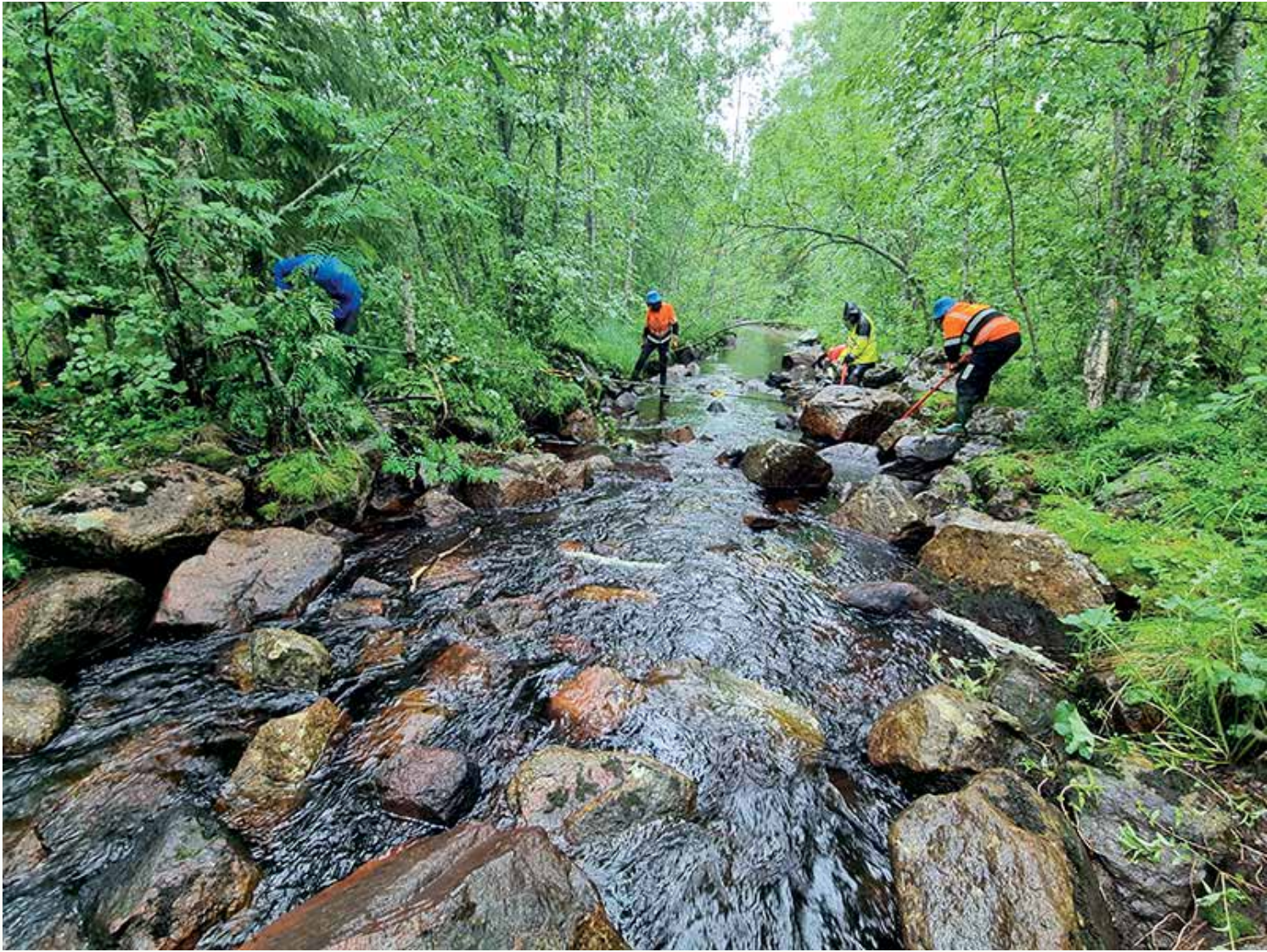
Koirajoen kunnostuksessa Salamajärven kansallispuistossa palautetaan aikoinaan perattuun uomaan kiviä ja puuainesta. Tavoitteena on monipuolistaa puron elinympäristöjä ja parantaa muun muassa uhanalaisen taimenen elinolosuhteita. Kuva: Christian Koivula / Metsähallitus.
