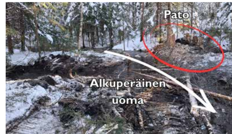
Kun vanhoja uomia vesitetään, oja joudutaan tukkimaan vahvoilla rakenteilla. Kuvassa Kaupinojan pato.
