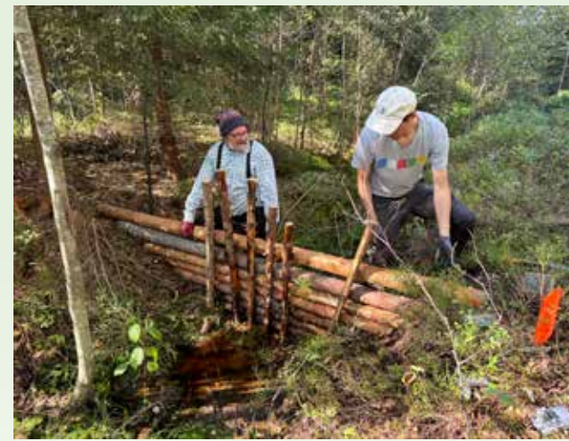
Padon rakentamista Terrisuolla.
