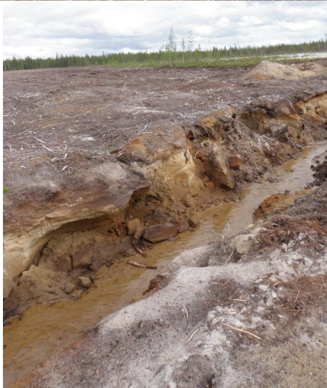
Liian ahdas siltarumpu on johtanut uoman siirtymiseen ja tien sortumiseen raakkupuroon
