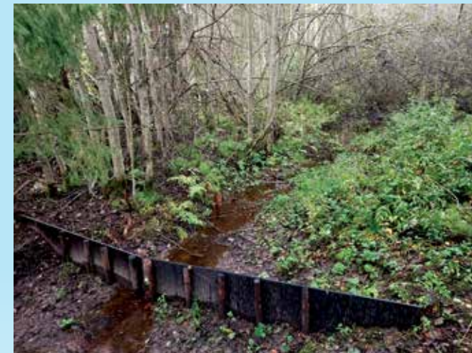
Veden viivytyksrakenne alavalla joutomaa-alueella odottaa sateisia aikoja.
