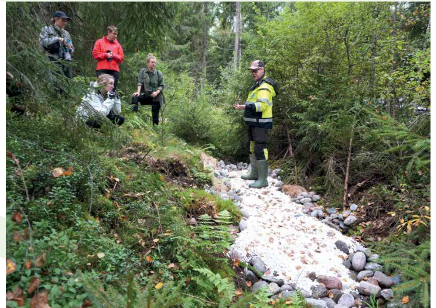
LUVYn hanketyöntekijä Mikko Melasniemi esittelee kalkkikiven ja biohiilen käyttöä veden suodattamiseen metsäojassa.
