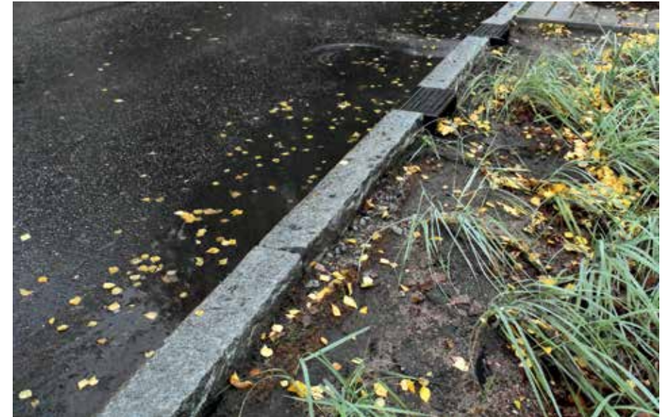
Hulevedet ohjataan kadulta kasvillisuuteen. Kuva: Kymijoen vesi ja ympäristö ry.
