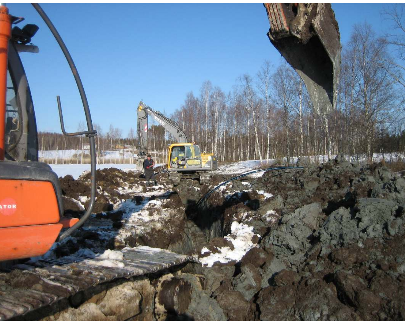
Verkoston rakentaminen käynnissä haja-asutusalueella Sastamalassa. (Kuva Jonne Säylä)
