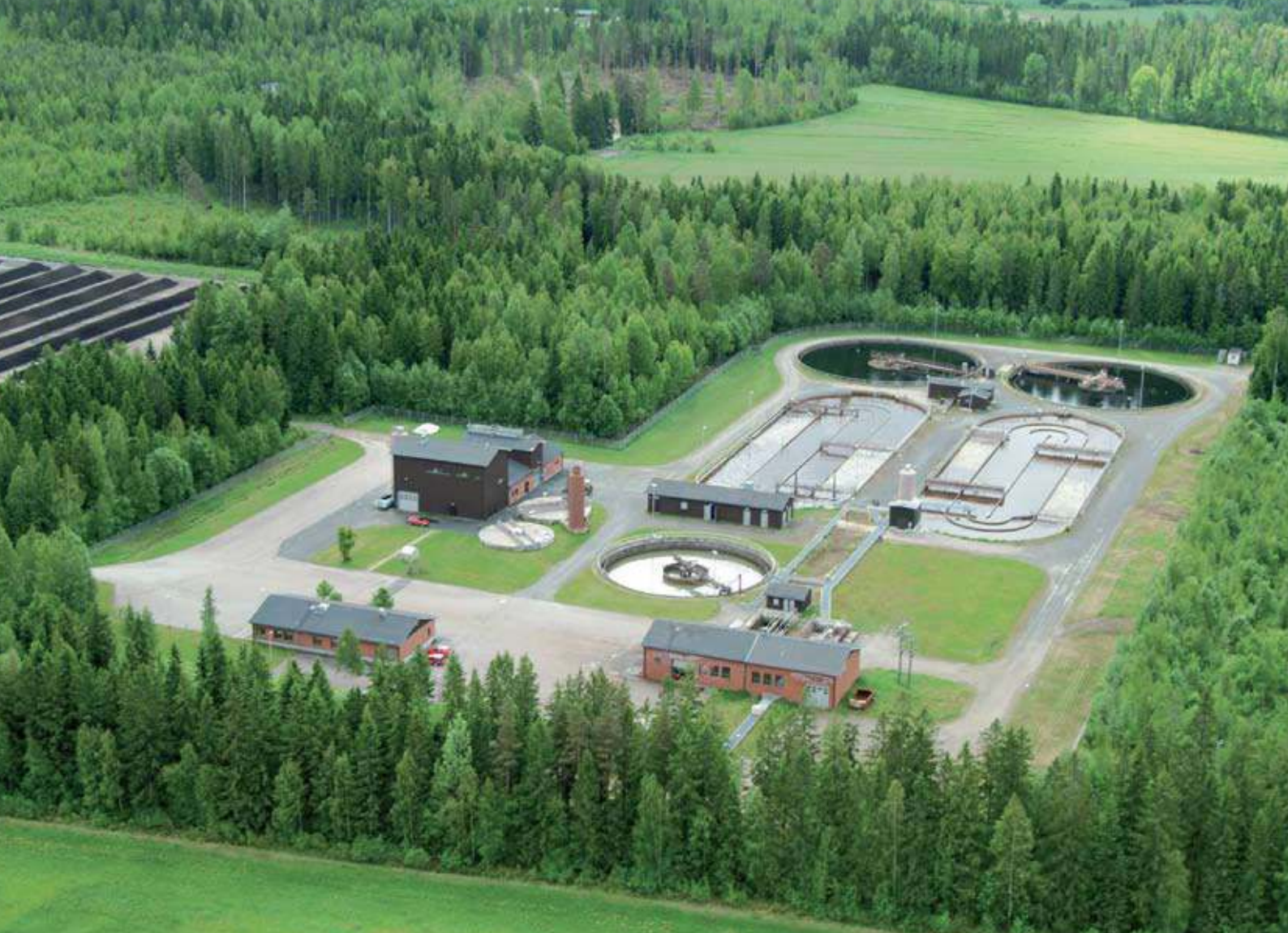
Kaltevan puhdistamo käsittelee 40 000 hyvinkääläisten jätevedet. Kuva: Hyvinkään Vesi
