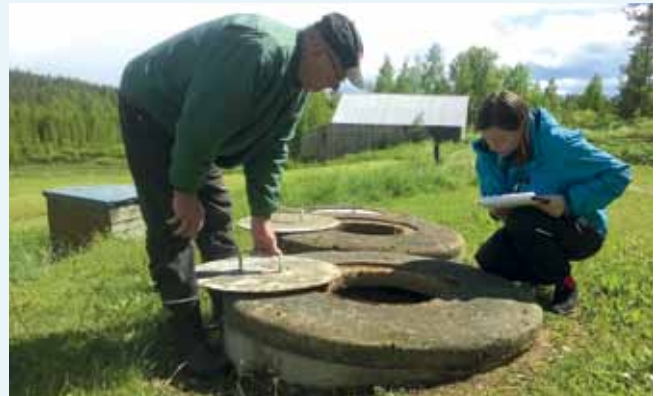
Jätevesineuvoja Seija Nissinen KVVY:ltä tutkii vanhojen saostussäiliöiden kuntoa Padasjoen Autoisilla. Kuva: Satu Heino/KVVY.
