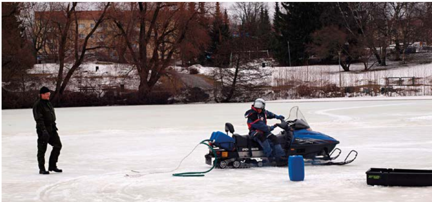
Järvien kunnostukselle voidaan antaa alkupotkua esimerkiksi kemiallisella käsittelyllä. KVVY:n tutkija Sakari Kivinen ja näytteenottaja Jyrki Ikävalko levittävät vedenkäsittelyainetta Tampereen Sorsalammen jäälle keväällä 2011. Jäiden sulaessa käsittelyaine saosti veden ylimääräisen fosforin pohjaan vähentäen lammen rehevyyttä. Kuva: Satu Heino
