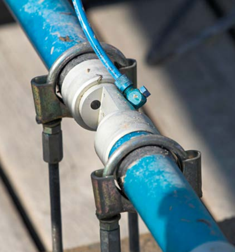
Scanin Spectrolyser mittaa vedestä sameuden ja nitraattityypen pitoisuuden lisäksi myös liukoisien orgaanisen hiilen pitoisuutta. Kuva: Pasi Valkama
